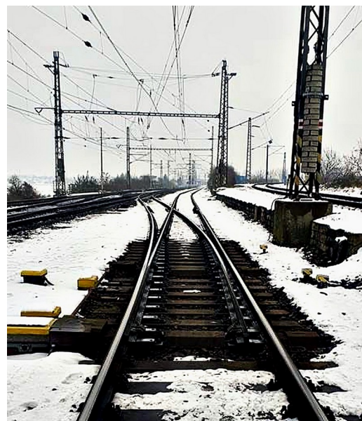
Výhybka s MAGUS EOv – pohled podél koleje
